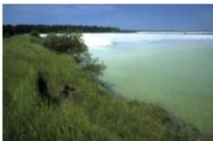
Slika 31. Nasipi oko deponije fosfogipsa
